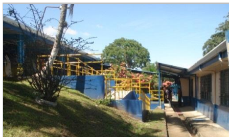
Rampa de acceso entre pabellones
