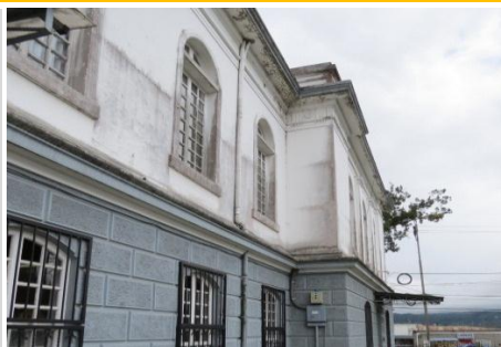
Fachada del edificio central
